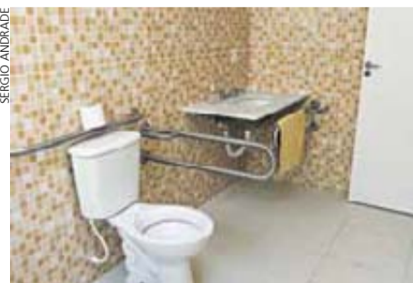
Barras de apoio e louças em altura adequada
